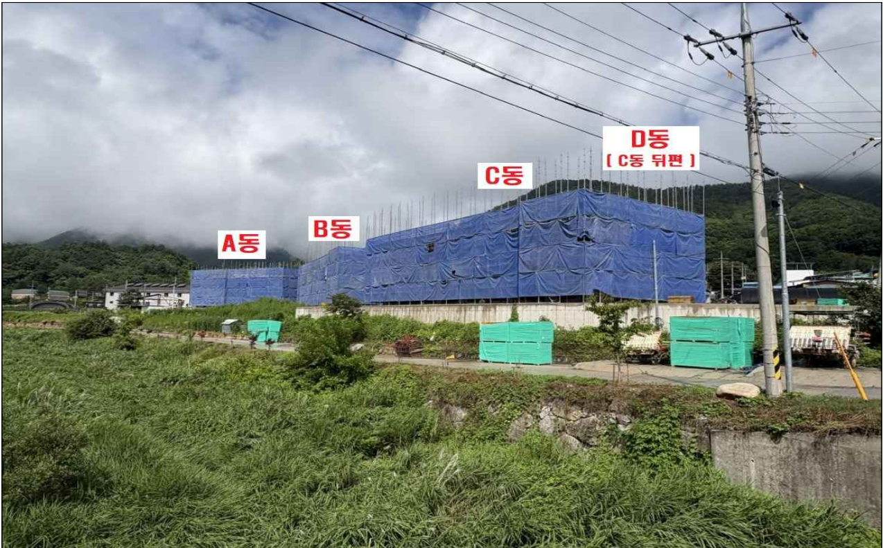
가북초 공사 현장(공정률 35%)
