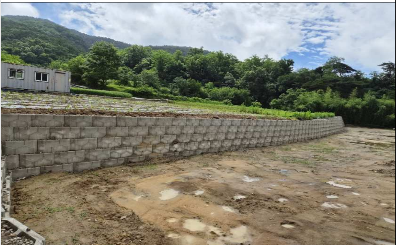
주상초 공사 현장(공정률 10%)
