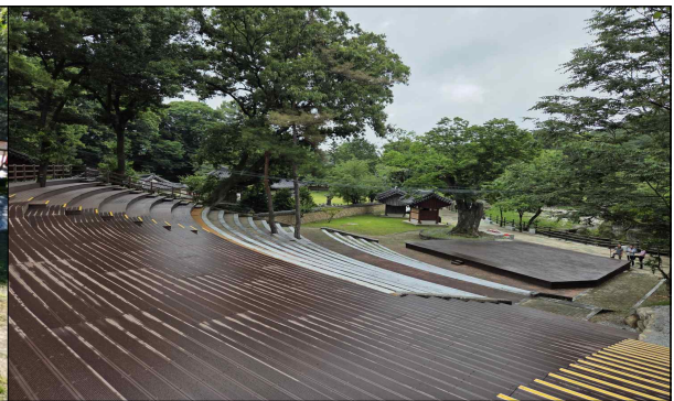
쉼터(객석) 설치 후
