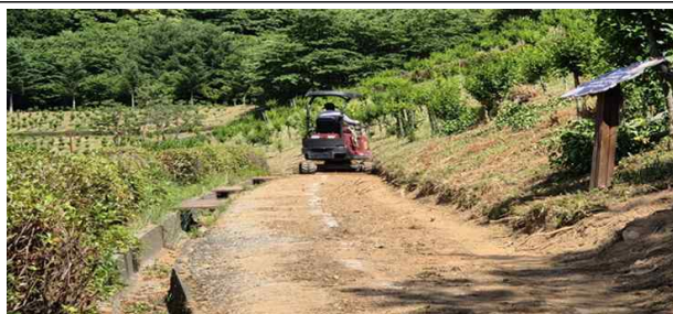
무궁화동산 산책로 정비공사(중)
