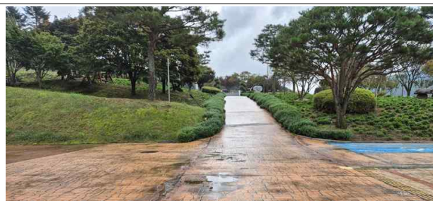
거창사건추모공원 추모마당 정비공사(전)
