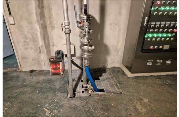
역사교육관 오수처리시설 펌프 교체
