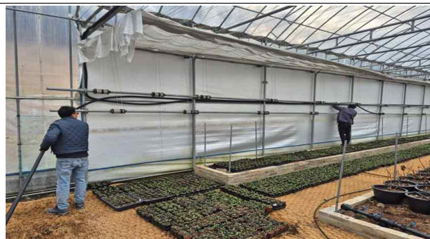
육묘하우스 전기케이블 연결 작업
