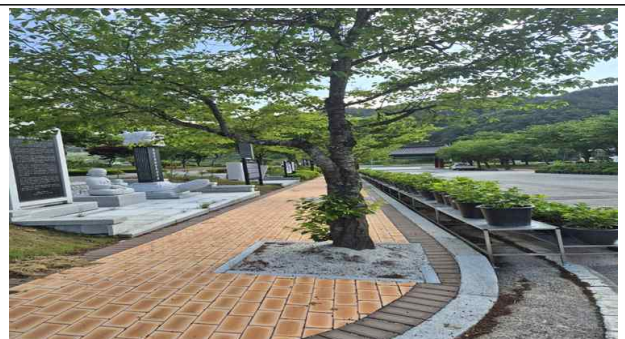
거창사건추모공원 보도블록 정비공사(후)
