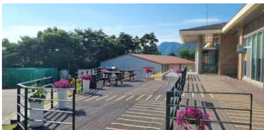
<데크 시공 전>
